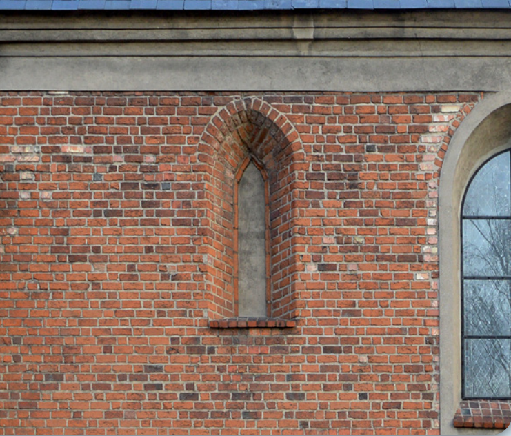
Detal okna wczesnogotyckiego w ścianie południowej fary (fot. Witold Miedziak)
