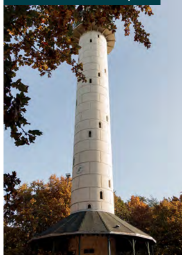
Wieża widokowa na Dziewiczej Górze
