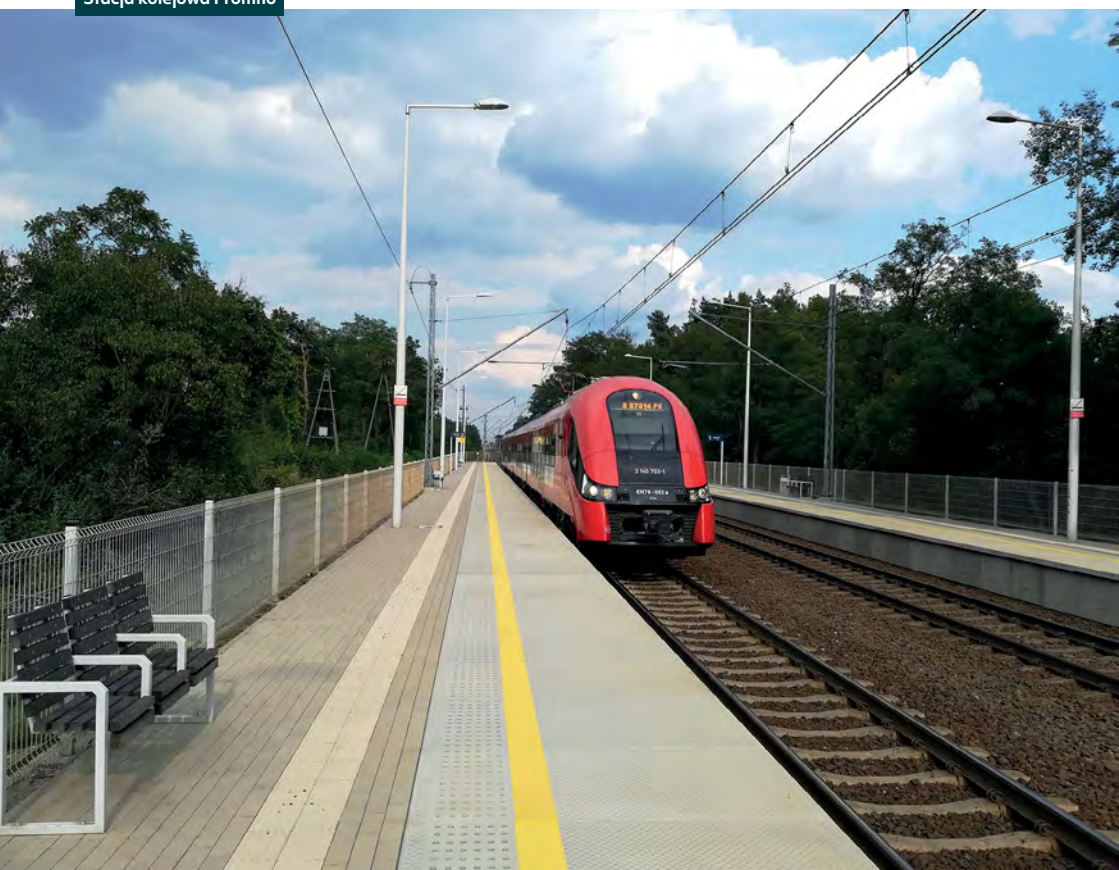
Stacja kolejowa Promno
